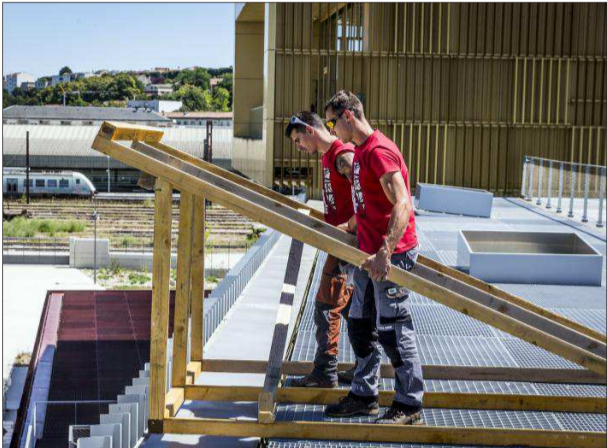
Ils ont fabriqué une structure en bois sur mesure, un support pour accrocher leur attirail d'escalade depuis le toit de l'Alpha.
