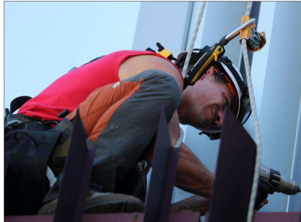
Il faut être à la fois solide physiquement et minutieux pour renforcer le bardage en aluminium. Vis par vis.
